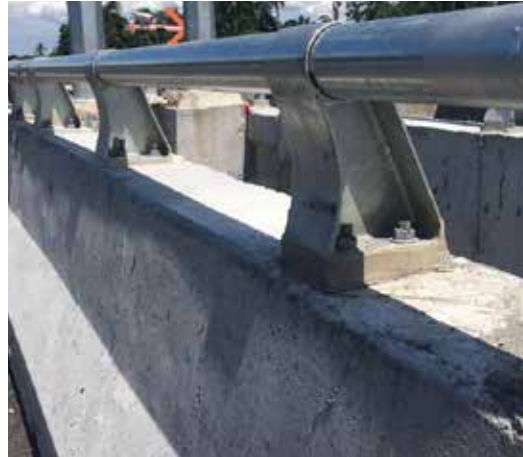
Material = BS EN 10025 S275 Galvanizing = BS EN ISO 1461
